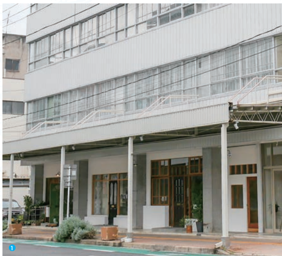
① ノトリビルの外観。1階にはチャレンジショップも。
